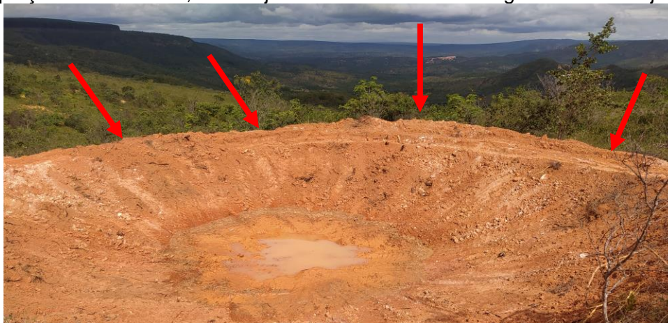
Figura 1. Demonstrando (setas) a execução do “cordão” de solo na parte de “fora” da crista da bacia de captação de enxurrada, com objetivo de escoamento de água no talude à jusante.
